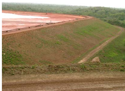
Abb. 16: Damm und Spülbecken für die Deponierung von Rotschlamm bei der Alumar in São Luis (CAMIN 2007)
